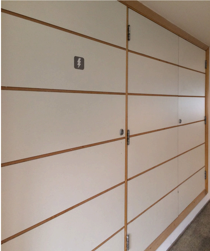
shafts para elétrica, telefonia e dados
