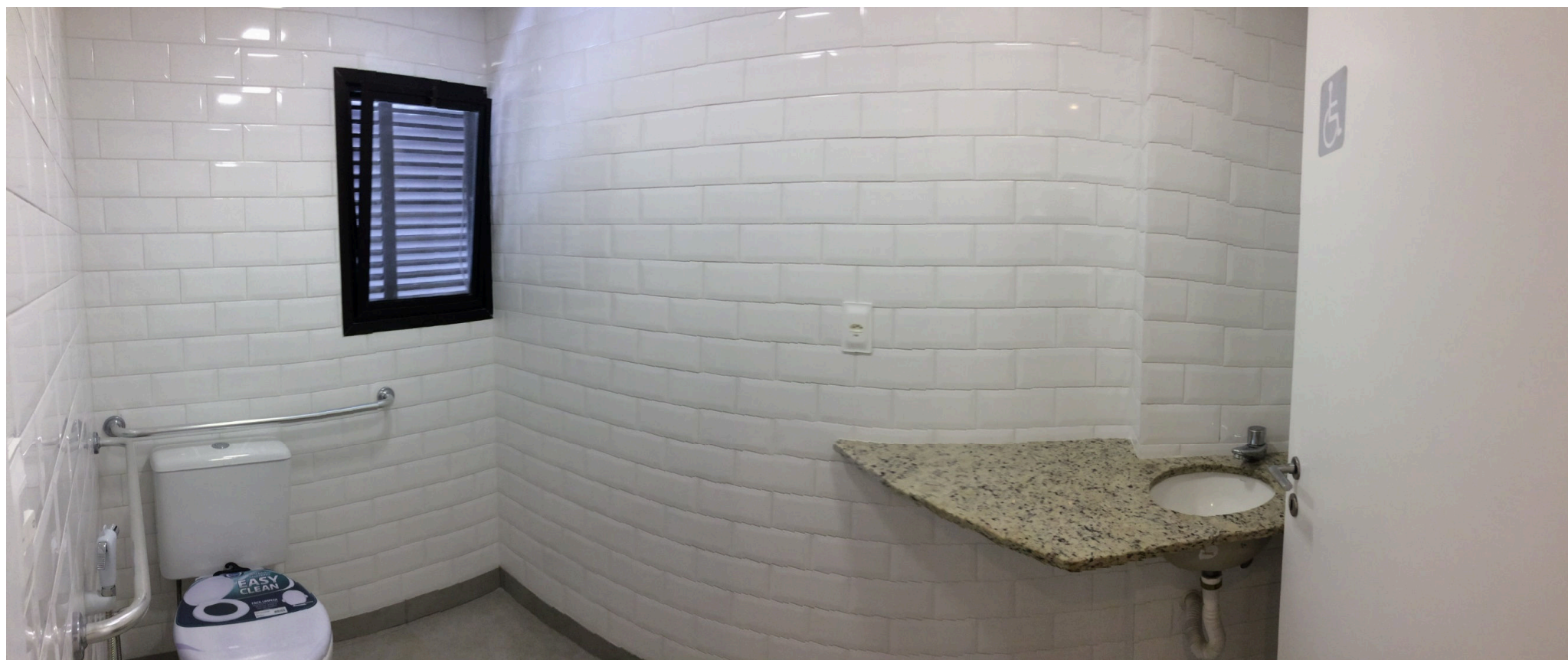
Banheiro adaptado para PNE
